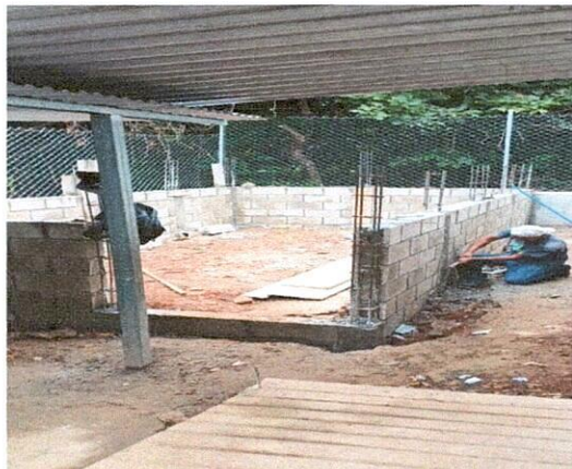
Foto1: Mejoramiento de estructura tipo pórtico e instalaciones de lámina troquelada en área de cocina, loza piso torta e instalación de piso cerámico antideslizante y polletón con extractor de humo.
