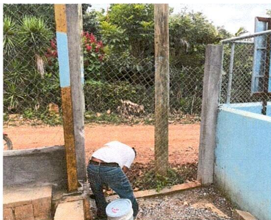
Foto 1: Mejoramiento en entrada principal del Instituto e instalación de portón.
