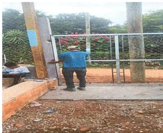
Foto 2: Mejoramiento en entrada principal del Instituto e instalación de portón.
